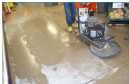
Primer Paso Pulido con Disco de Grado 400
